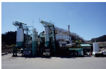
アスファルトプラント(津市)
